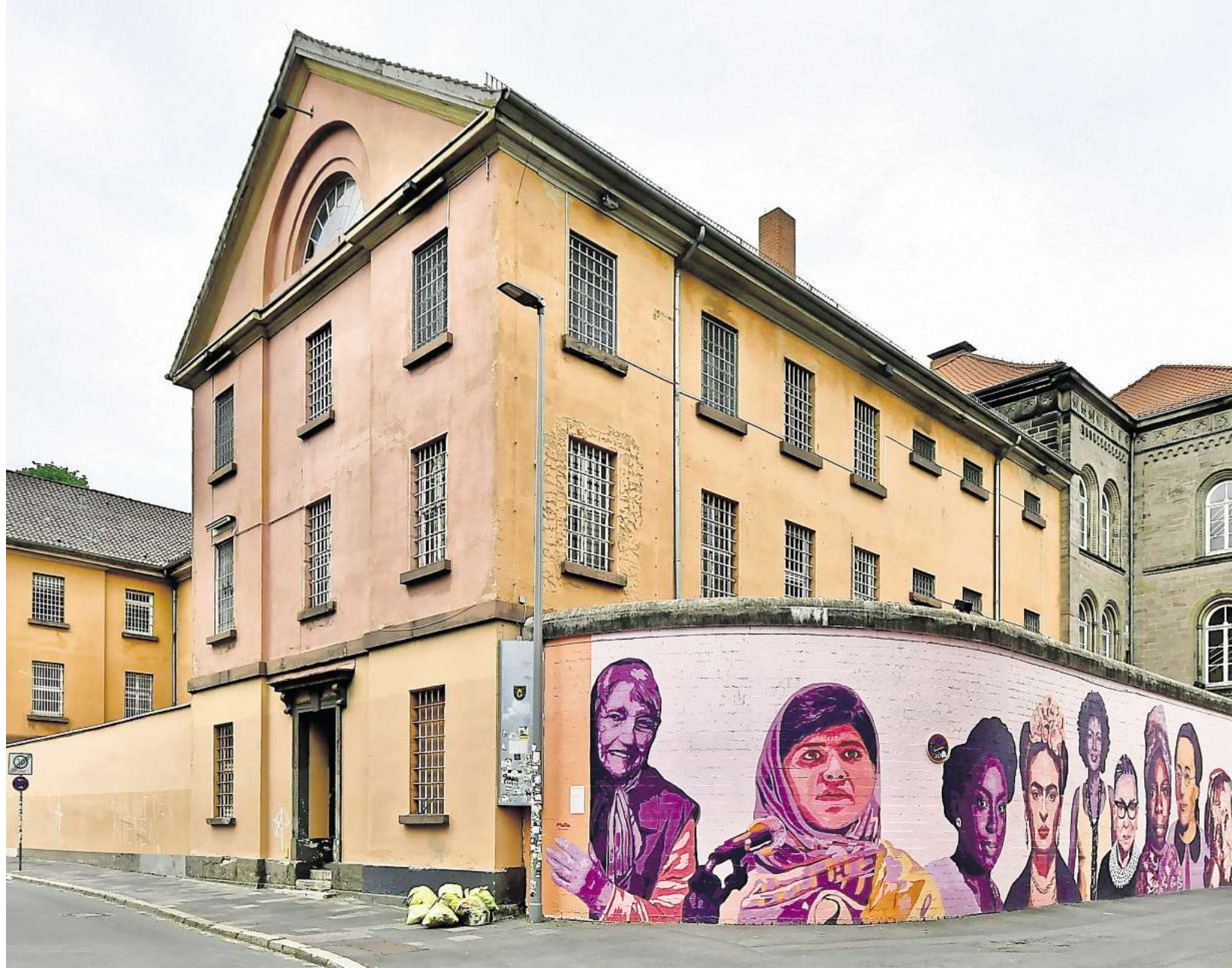
Nachnutzer gesucht: die ehemalige Justizvollzugsanstalt (JVA) am Waageplatz in der Innenstadt von Göttingen.
